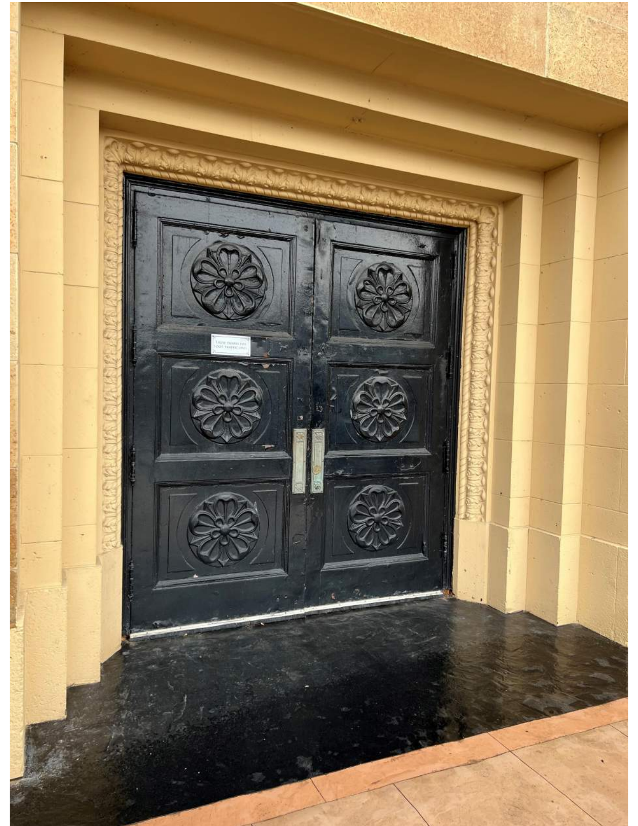
EXISTING EXTERIOR DOOR
