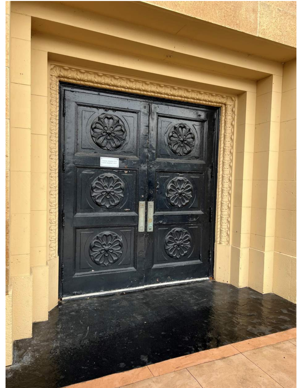
EXISTING EXTERIOR DOOR
