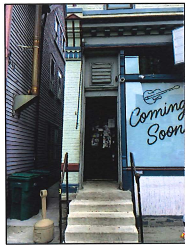
ENTRY STAIR & DOOR
