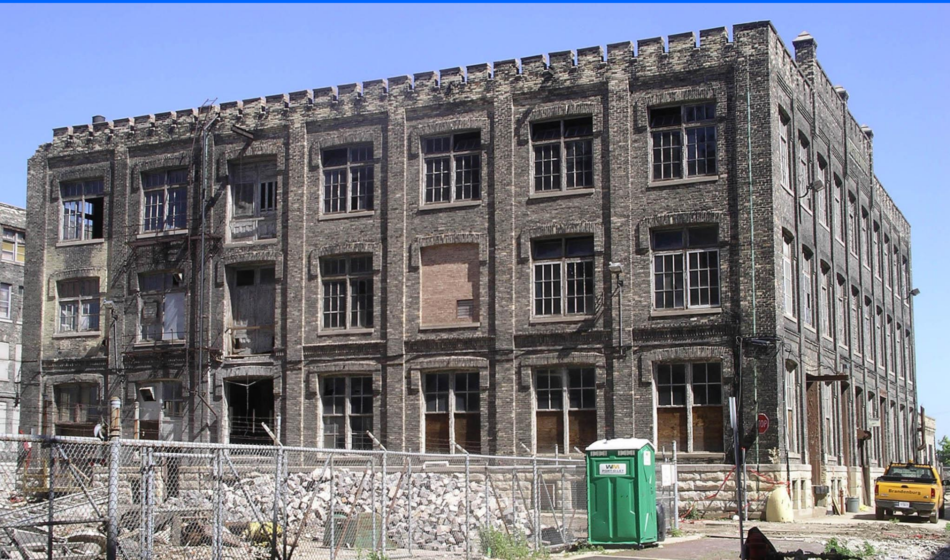
Pabst Bldg. #10 before
