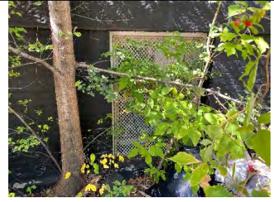
E104-03: Exterior view
