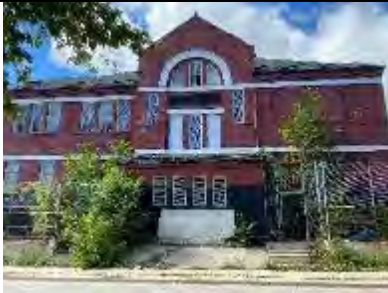
E311-E313-01: Exterior View
