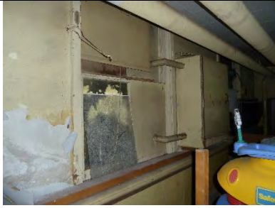
E104-01: Interior view
