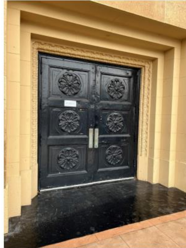
EXISTING EXTERIOR DOOR
