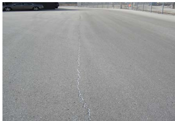
Longitudinal cracking
