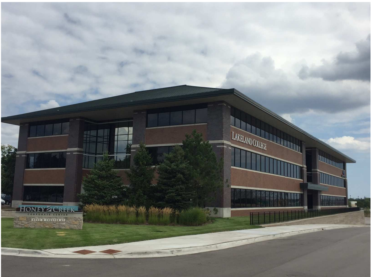
EXISTING COLLEGE TENANT
