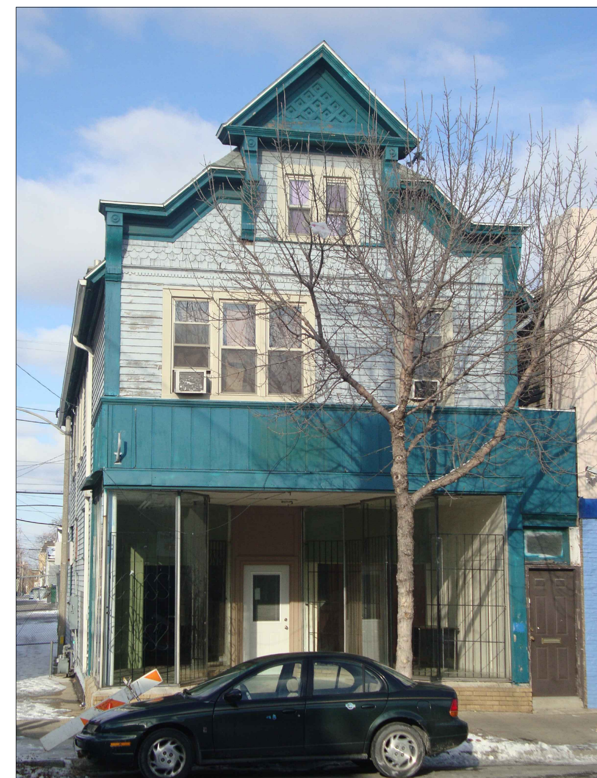
6 PHOTO OF EXISTING SOUTH ELEVATION SCALE: N.T.S.
