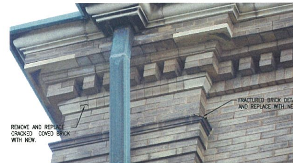
12 BRICK CRACKING SCALE: N.T.S.
