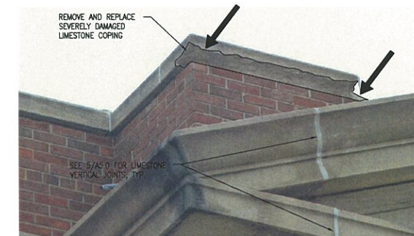
8 DAMAGED LIMESTONE COPING SCALE: N.T.S.
