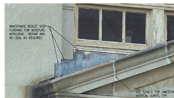
10 EXISTING REGLET FLASHING SCALE: N.T.S.
