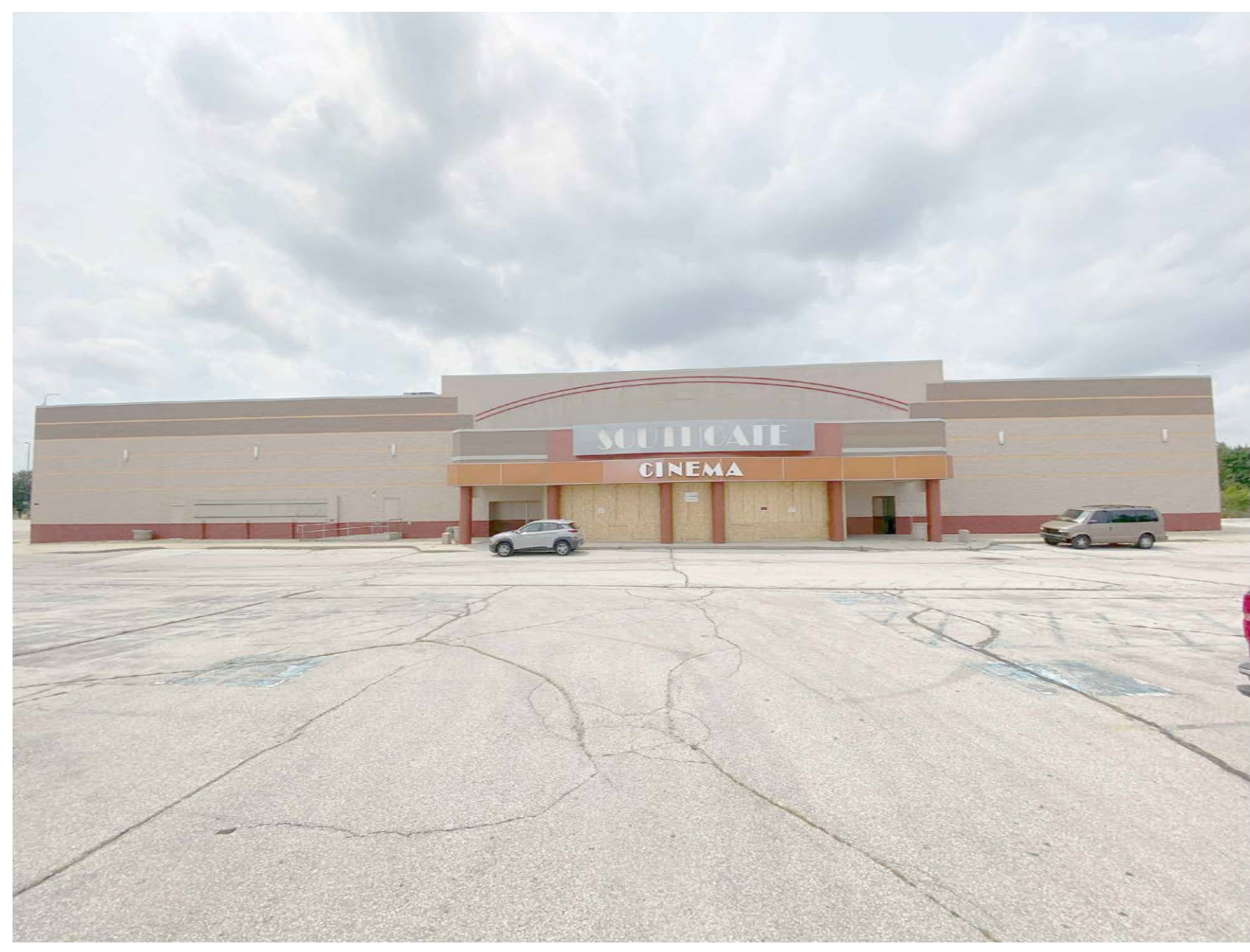
2 EXISTING EAST PHOTO N.T.S.
